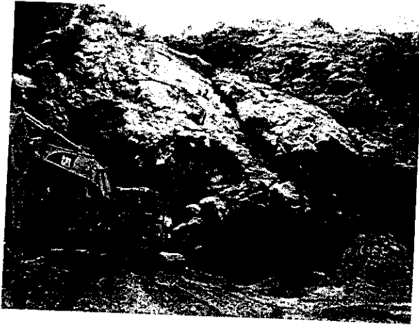
Foto N° 9. Fecha: 08 de Septiembre de 2008. Ubicación: Cantera INGECOST. Observaciones: Antiguo sitio de explotación, retroexcavadora
